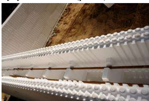
Рис. 2. Укладка первого ряда несъемной опалубки на фундамент здания
